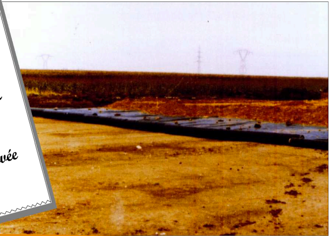
Couche de forme sur géotextile tissé
