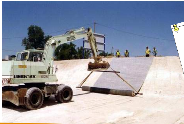
Installation de géosynthétique bentonitique Lintobent sur une paroi de bassin
