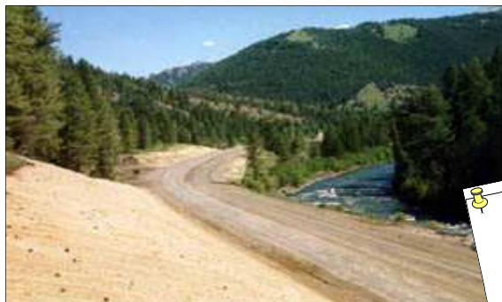
Application de paillis sur talus routier
