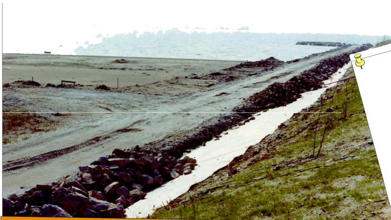
Enrochements sur géotextile Geo PP
