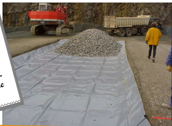
Géomembrane PVC Agrilac installée directement sous ballast
