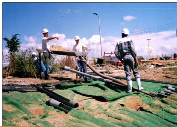
Installation d'un matelas ProFix
